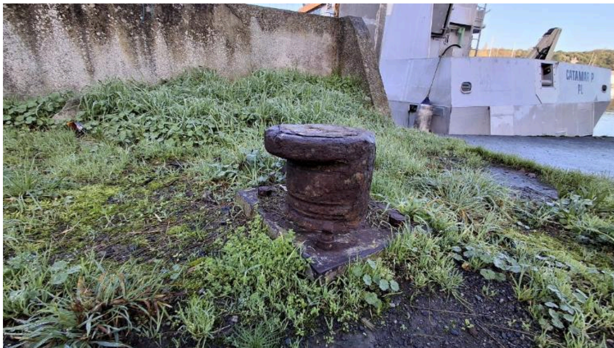
Bitte d'amarrage et traces d'usure
