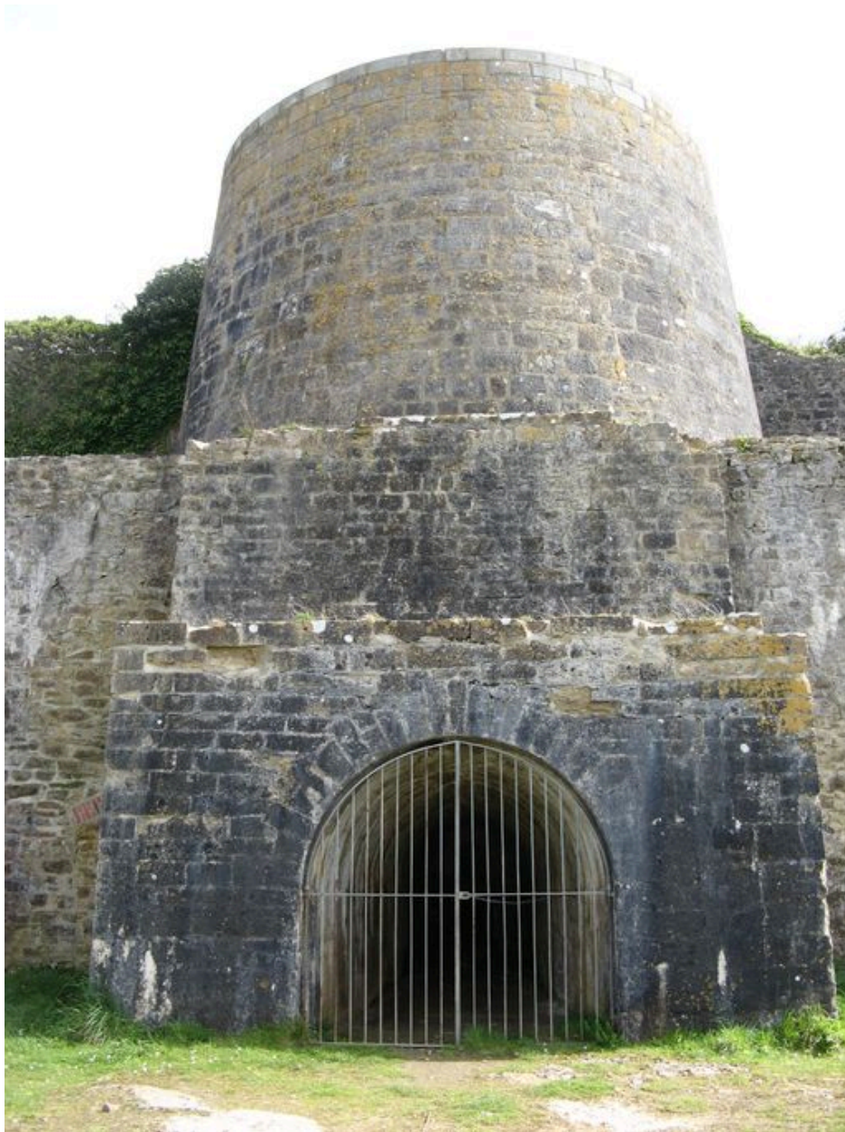
Détail du four à chaux de Rozan
