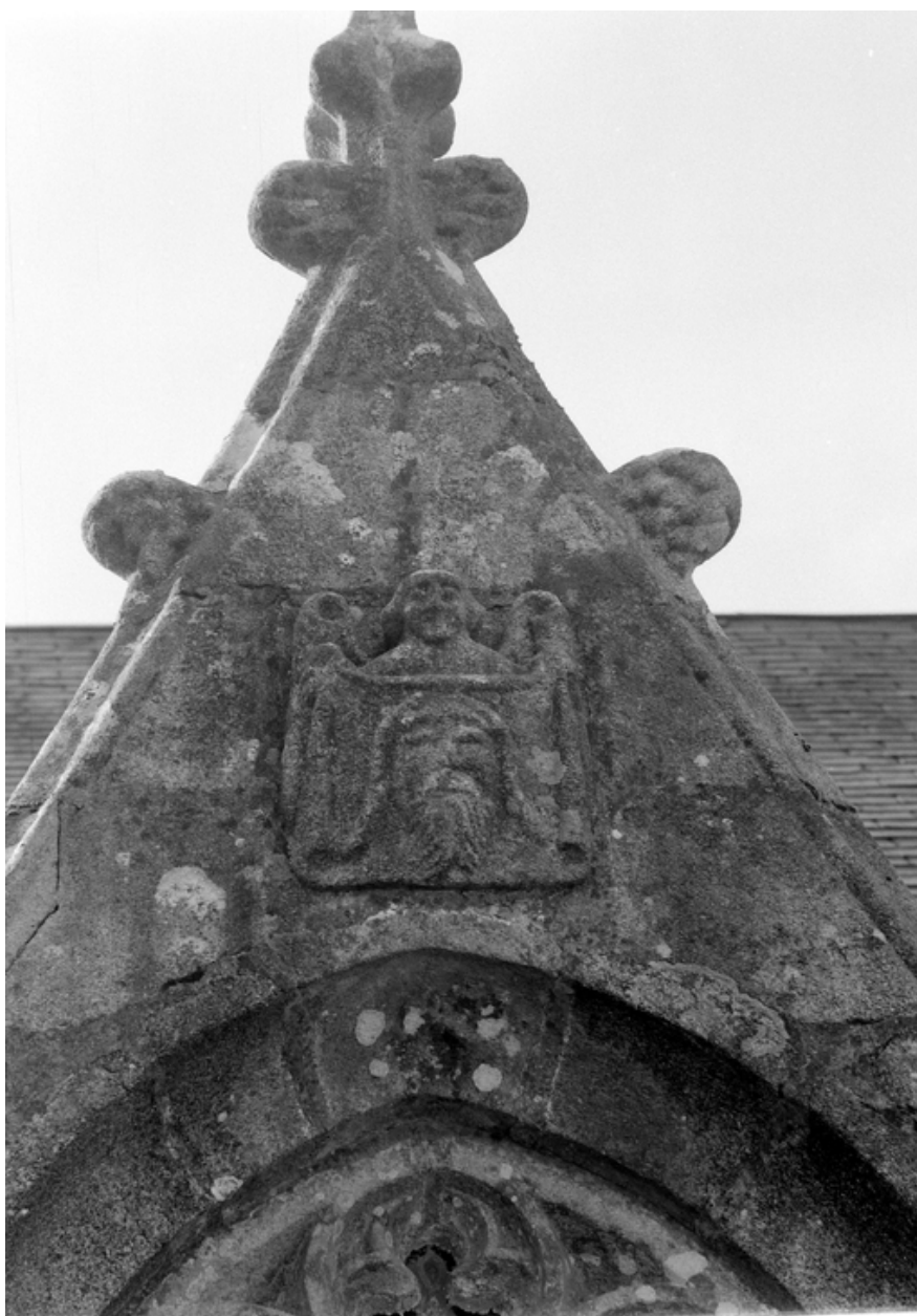
Fenêtre ouest du mur nord, détail : ange présentant la sainte Face
