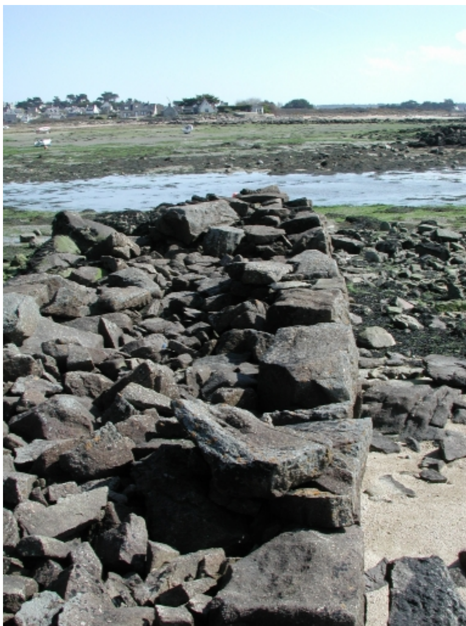
Vue de la plateforme du 1er quai
