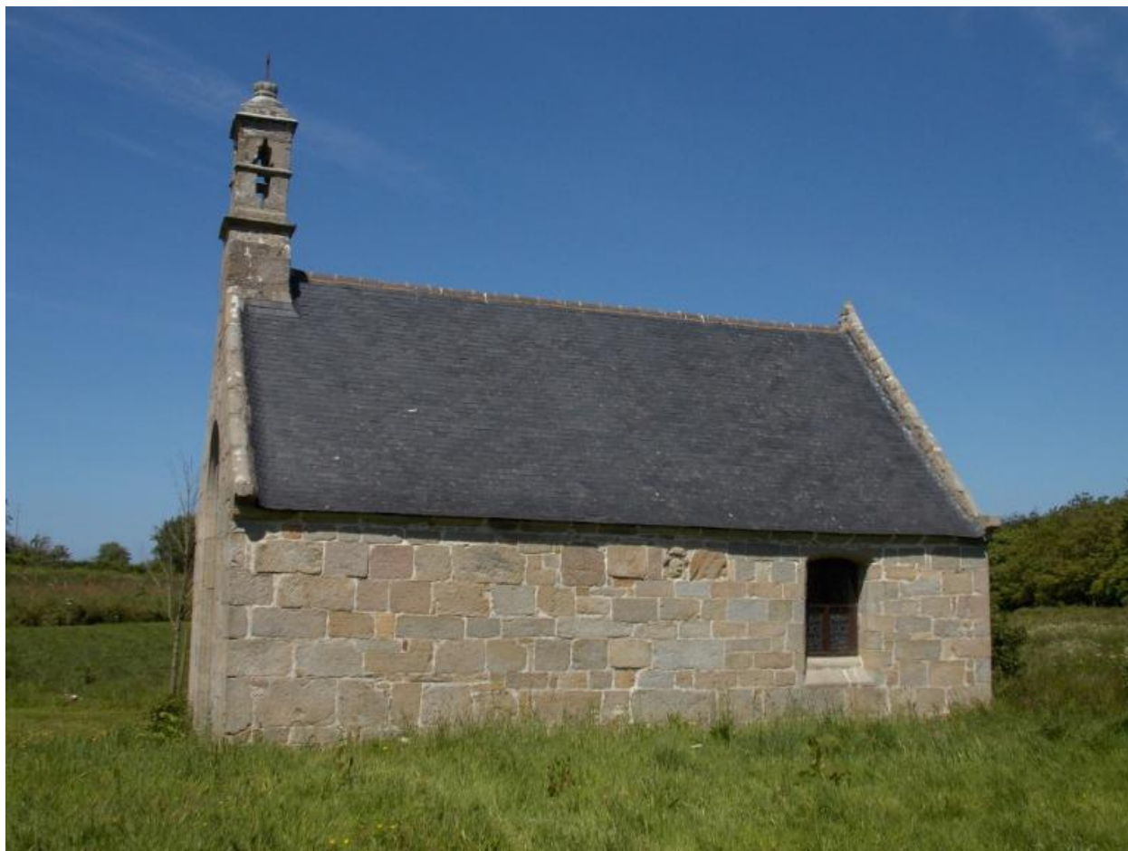
Chapelle Saint-Laurent dite de Tromenec
