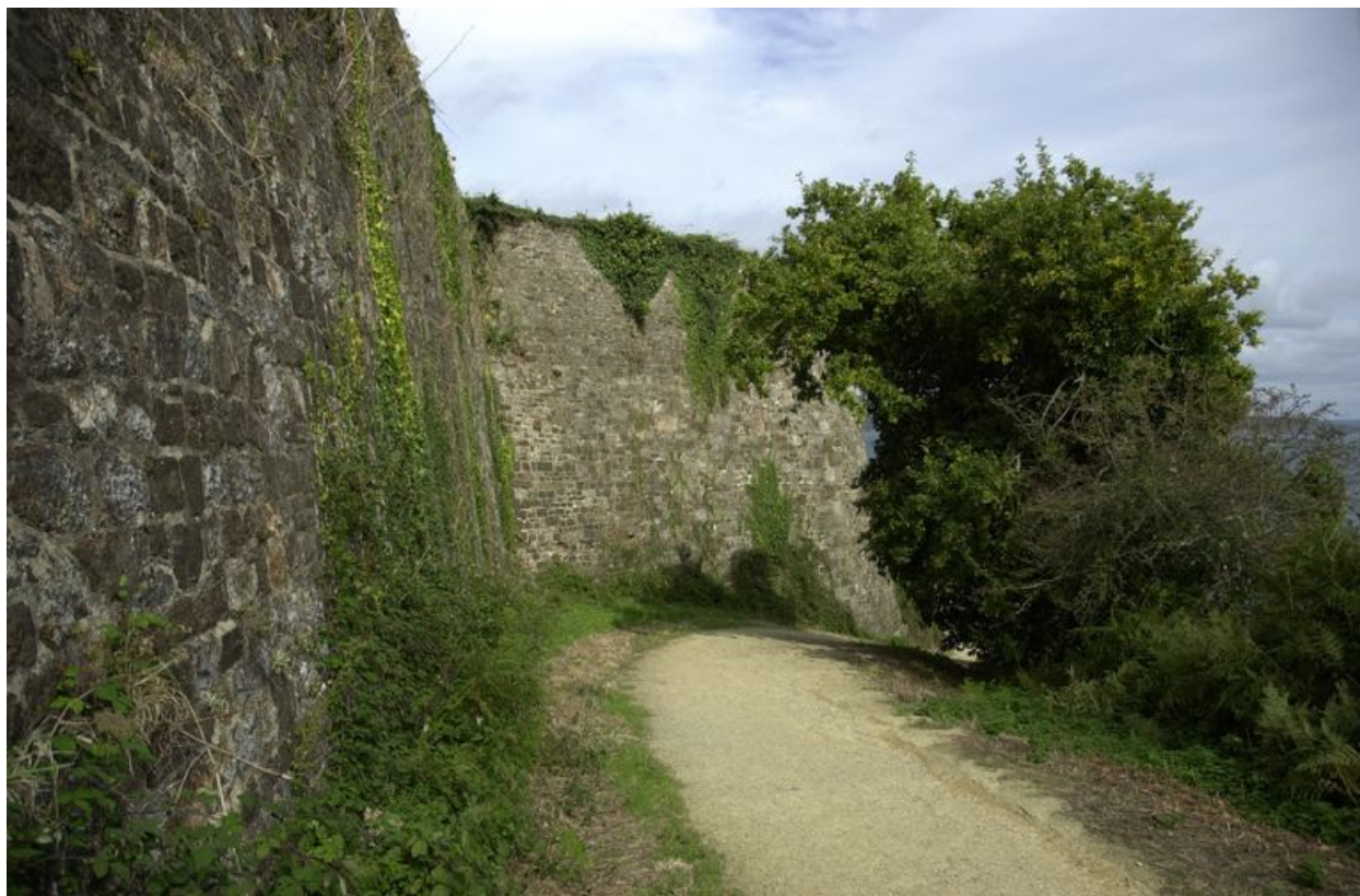
Vue du fort de Lanvéoc : demi-bastion de l'extrémité est
