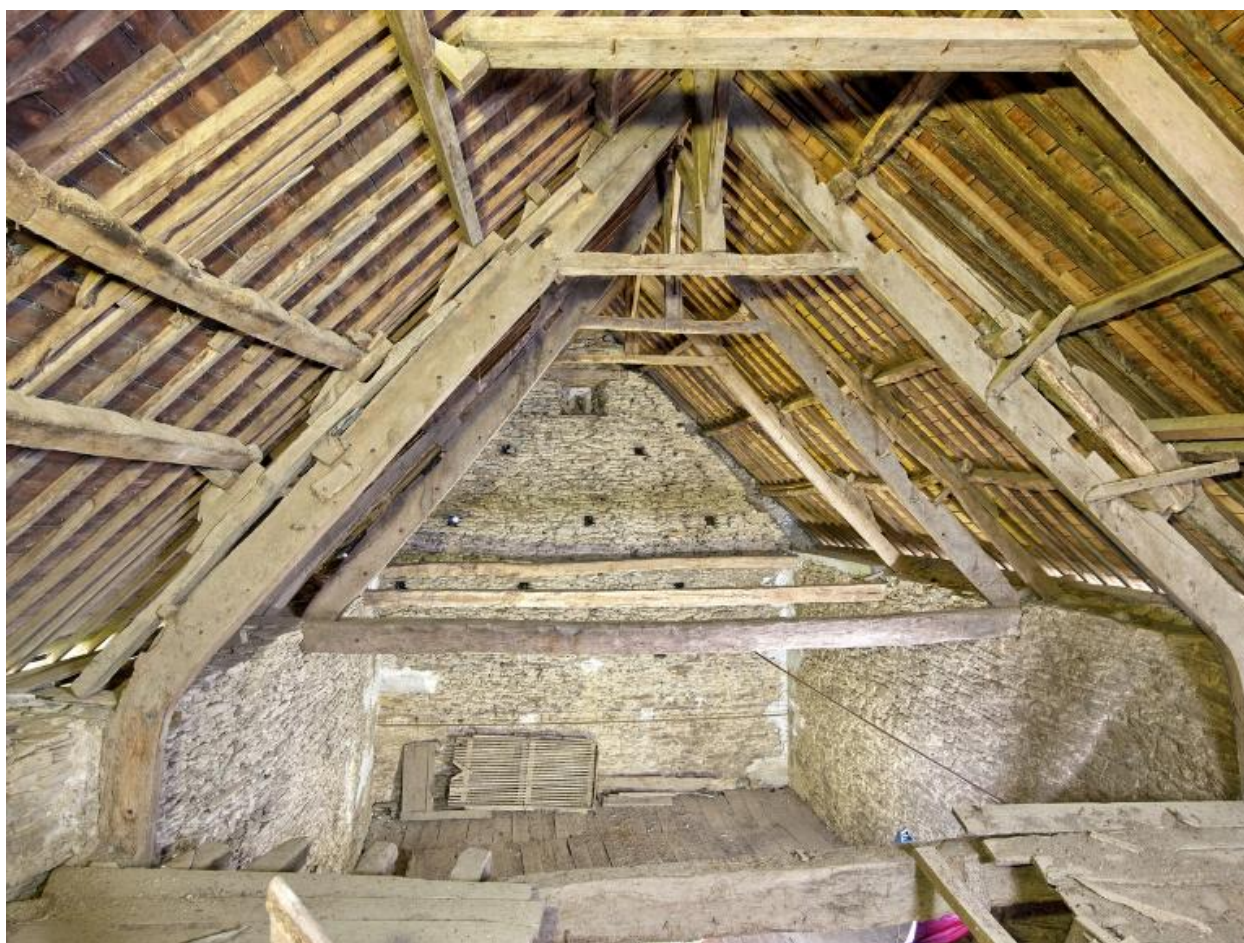
Dépendance, double-grenier sous combles à surcroît, vue générale
