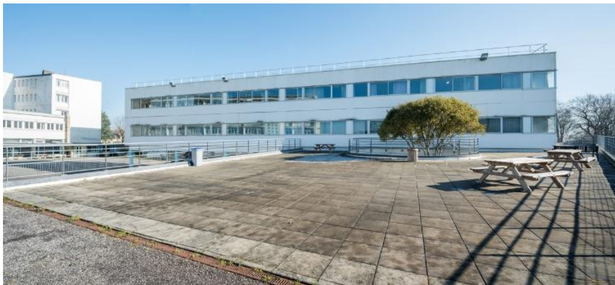
Façade ouest de l'externat de 2001 (P. Ruelland et M. Quéré, architectes).
