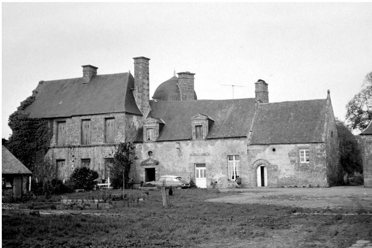
Vue générale façade sud ouest
