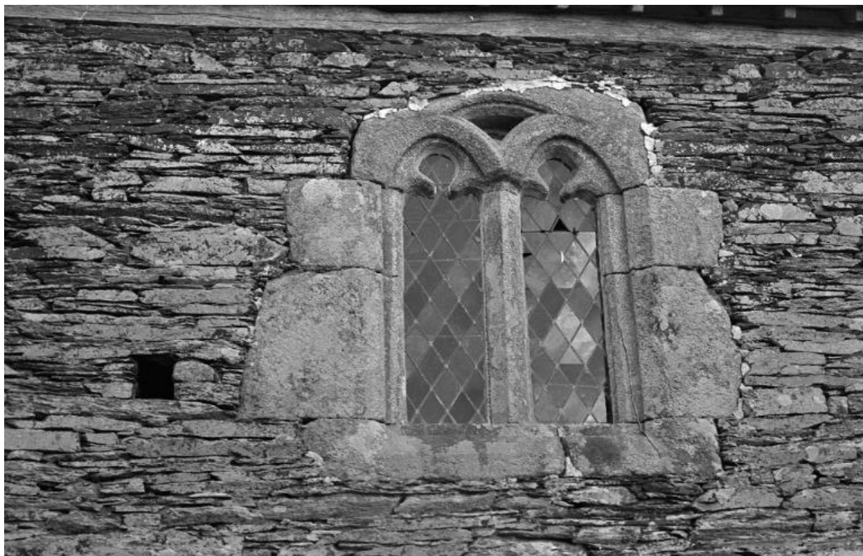
Détail des baies
