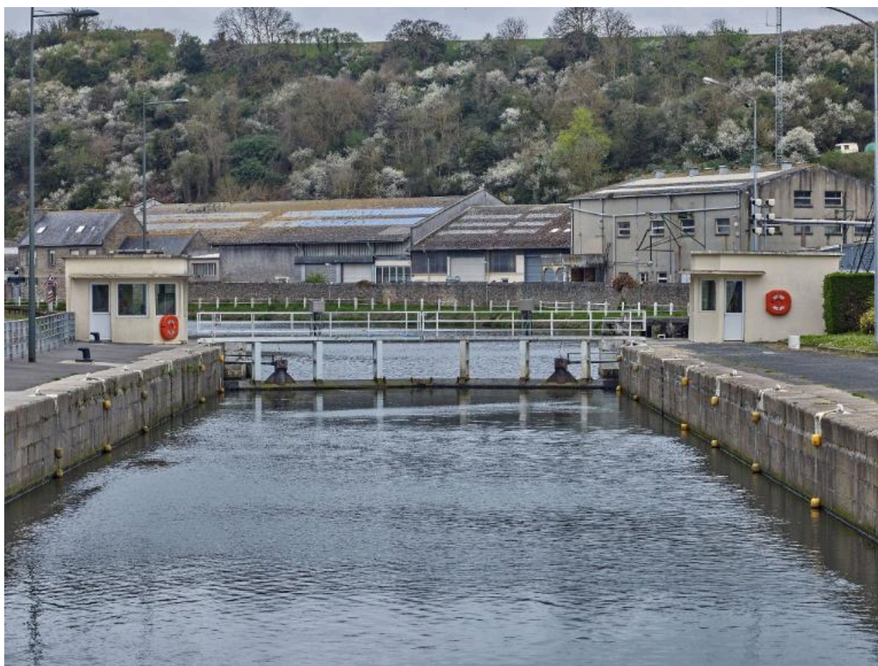
Les portes amont de l'écluse
