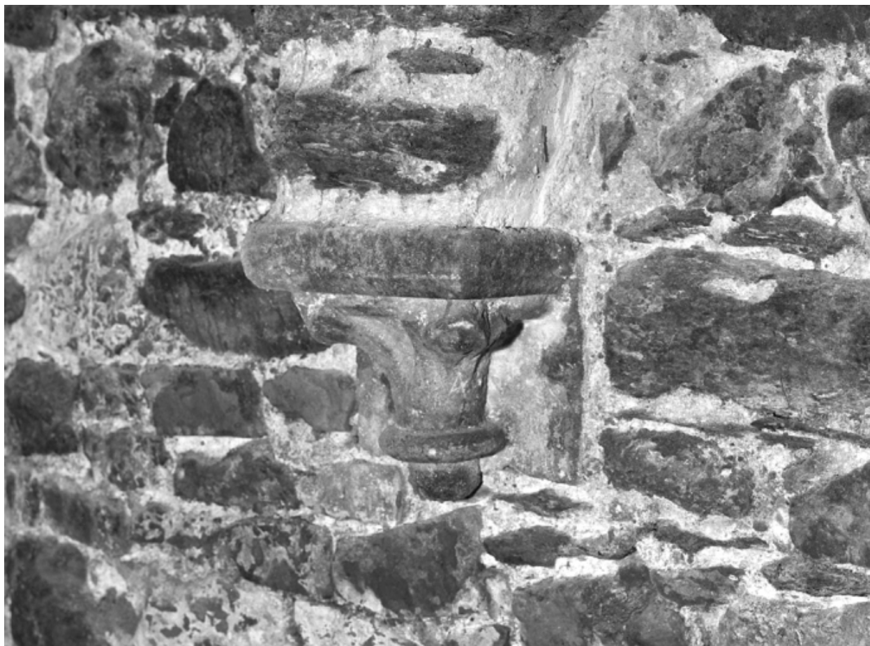
Ancien bâtiment claustral ; cave du presbytère : culot sculpté en remploi
