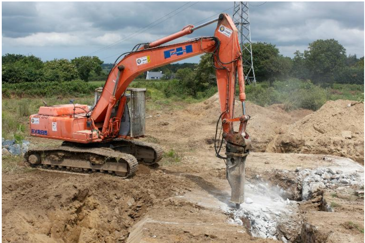
Déconstruction d'un bunker de type 502
