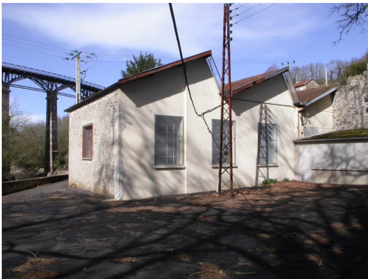
La "salle de relayage", façade sud.
