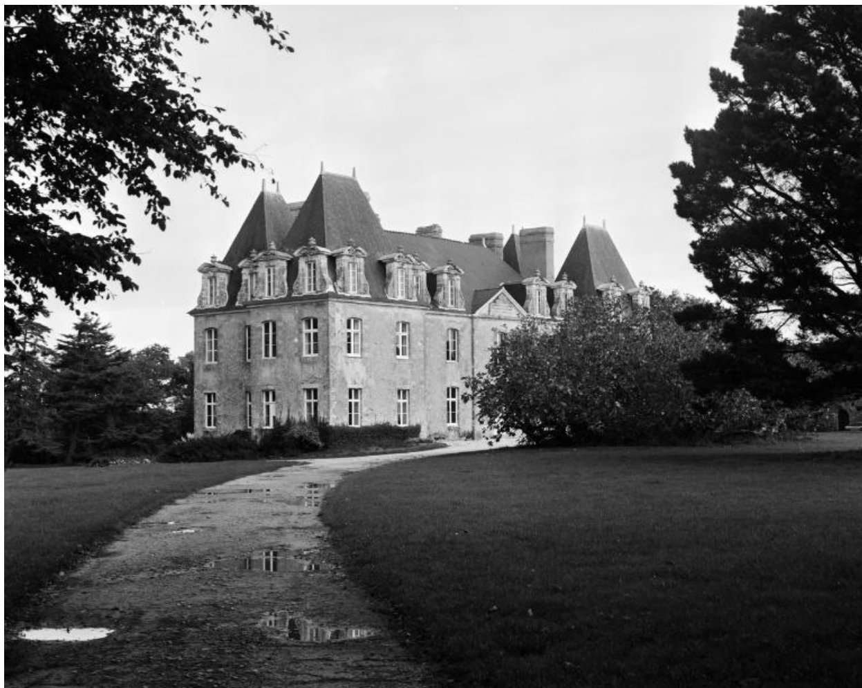
Château, vue générale sud-ouest.
