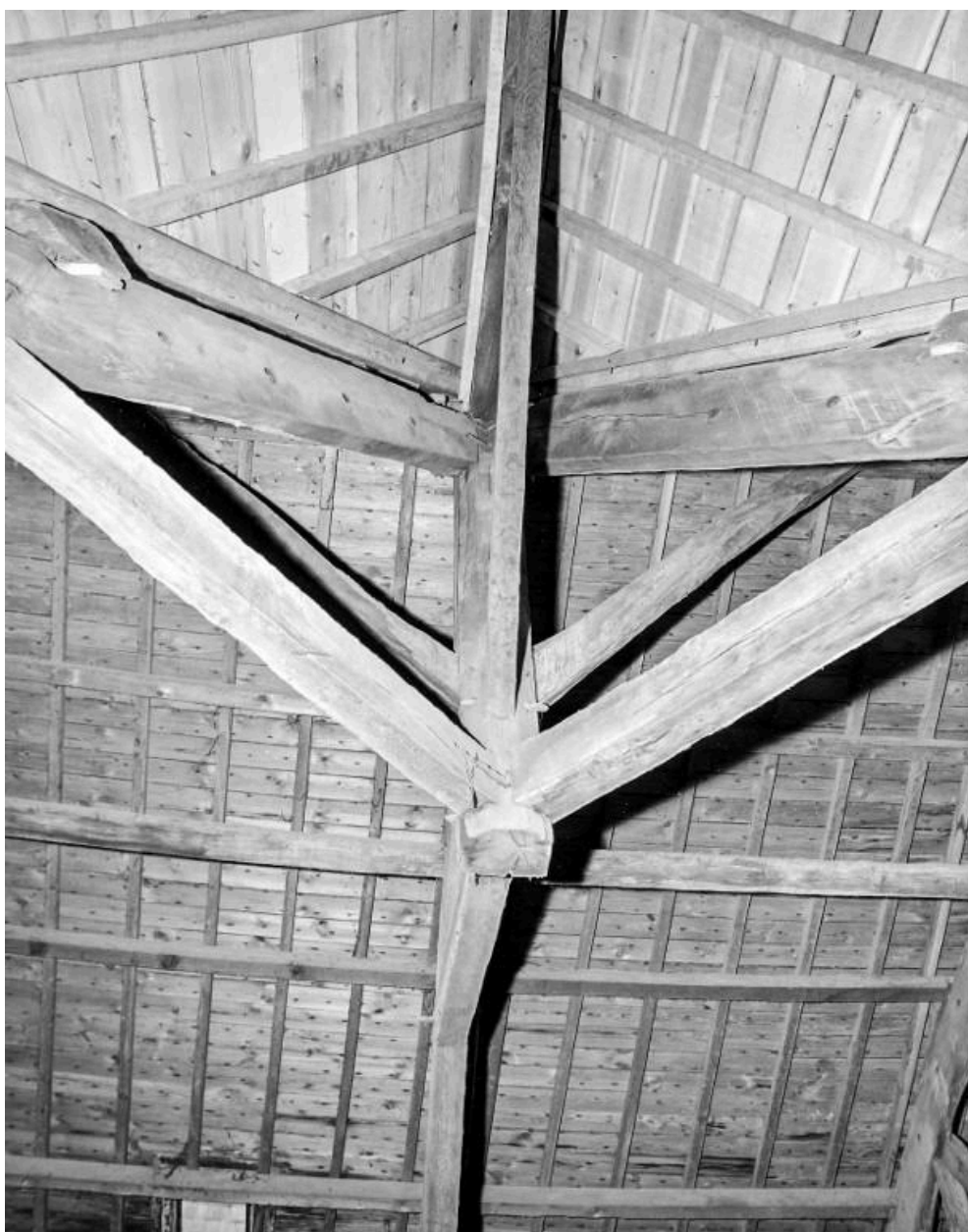
Charpente, noe des toits longitudinal et transversal.
