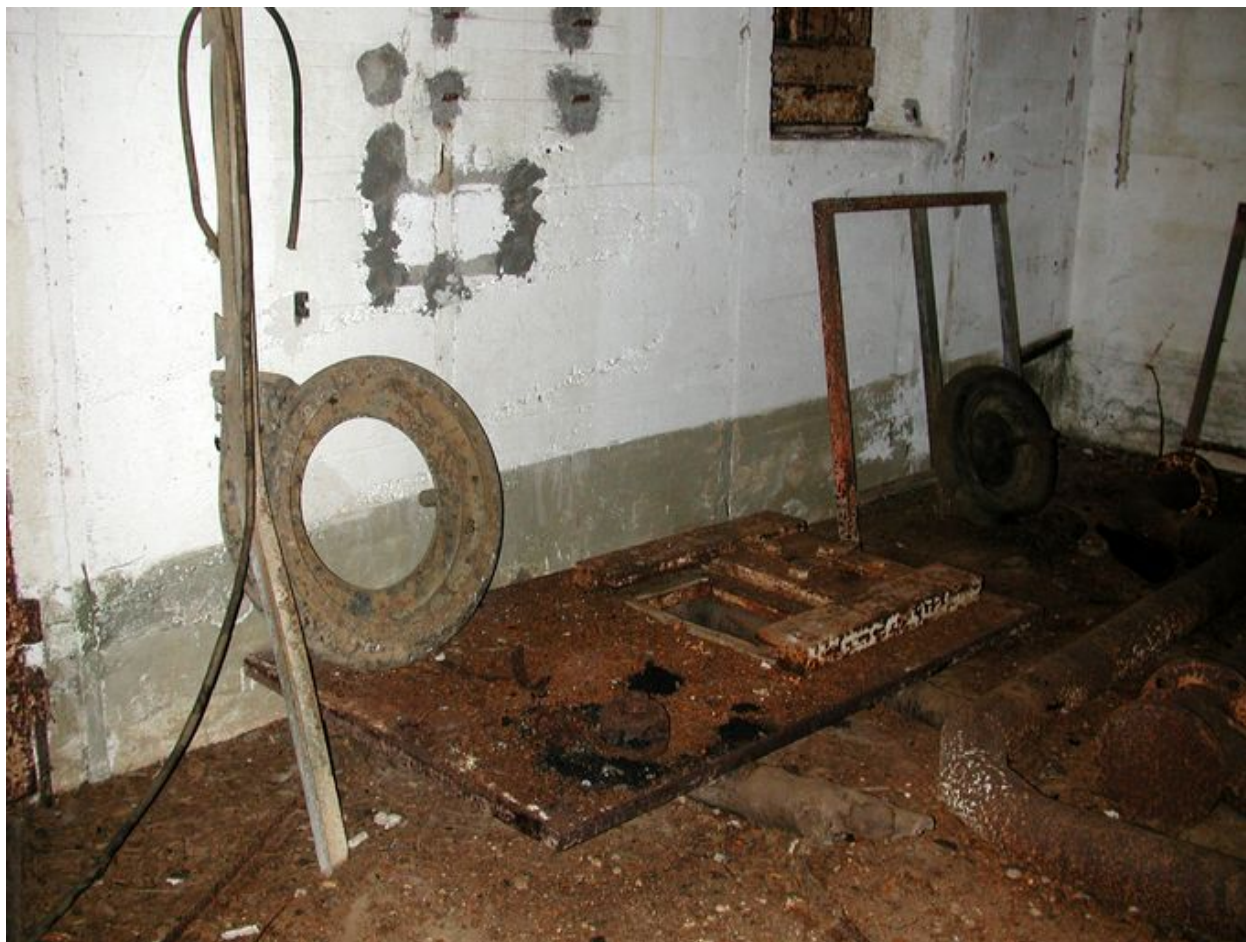
Vue de la chambre de troupe de gauche : créneau blindé gisant au sol (état en 2003)
