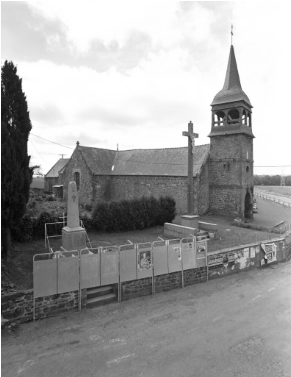
Vue générale nord-ouest
