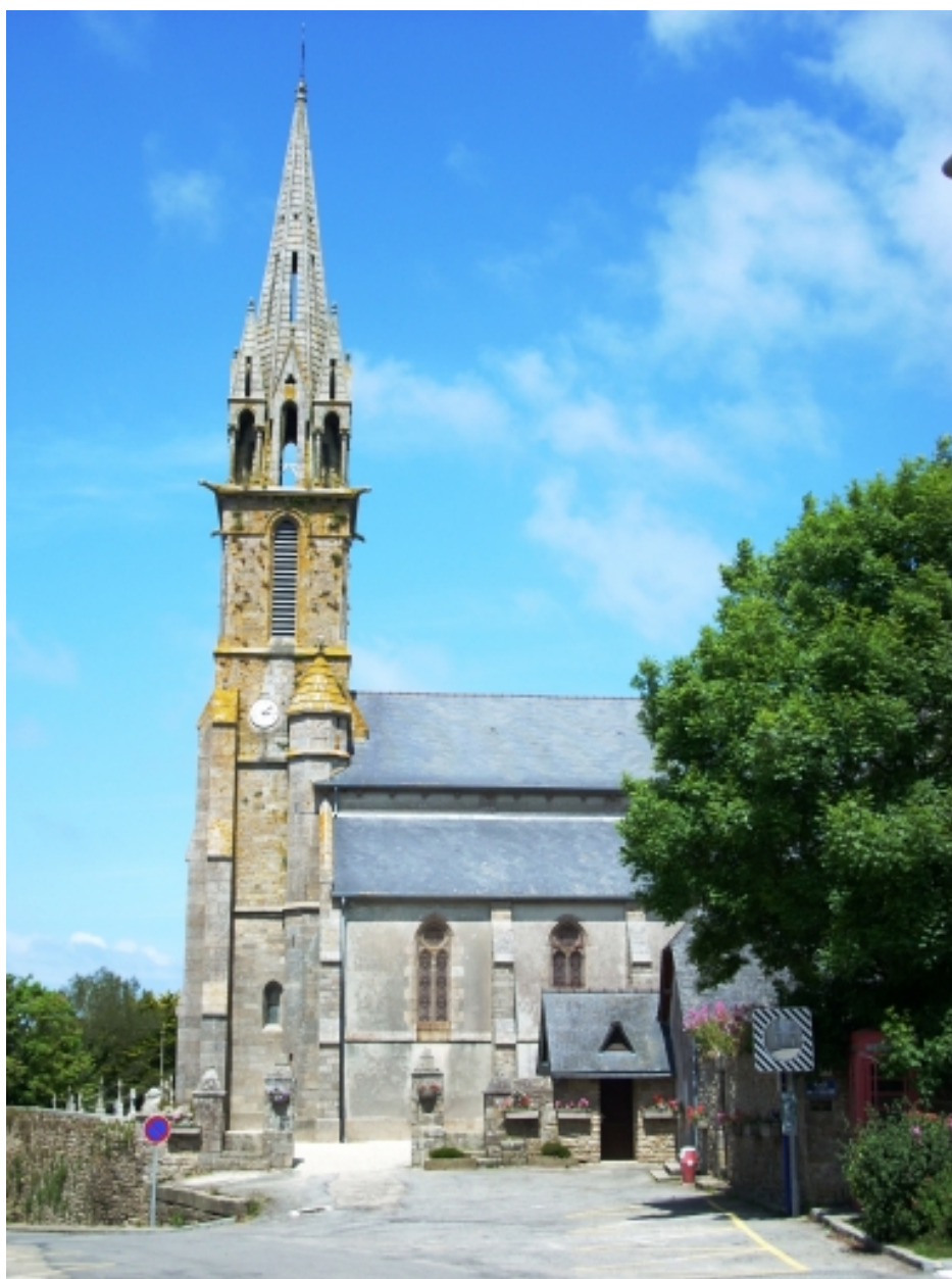
Landunvez, église paroissiale : vue générale sud
