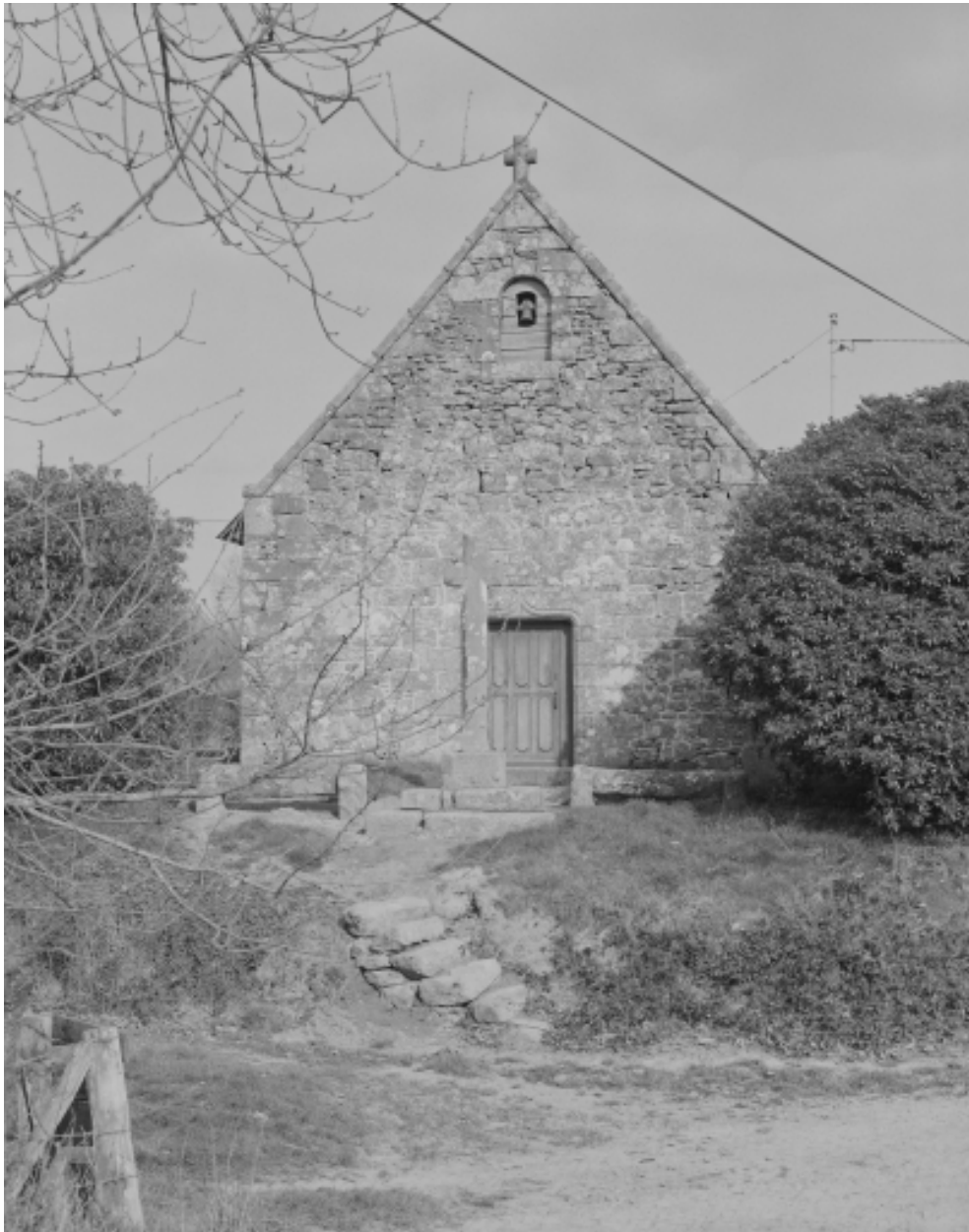
Elévation Ouest : vue générale
