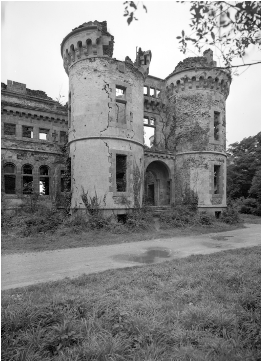
Château (vestiges), élévation nord-ouest.
