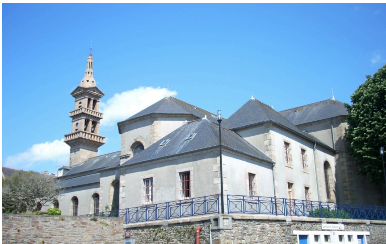
Brest, église Saint-Joseph : vue générale sud-est
