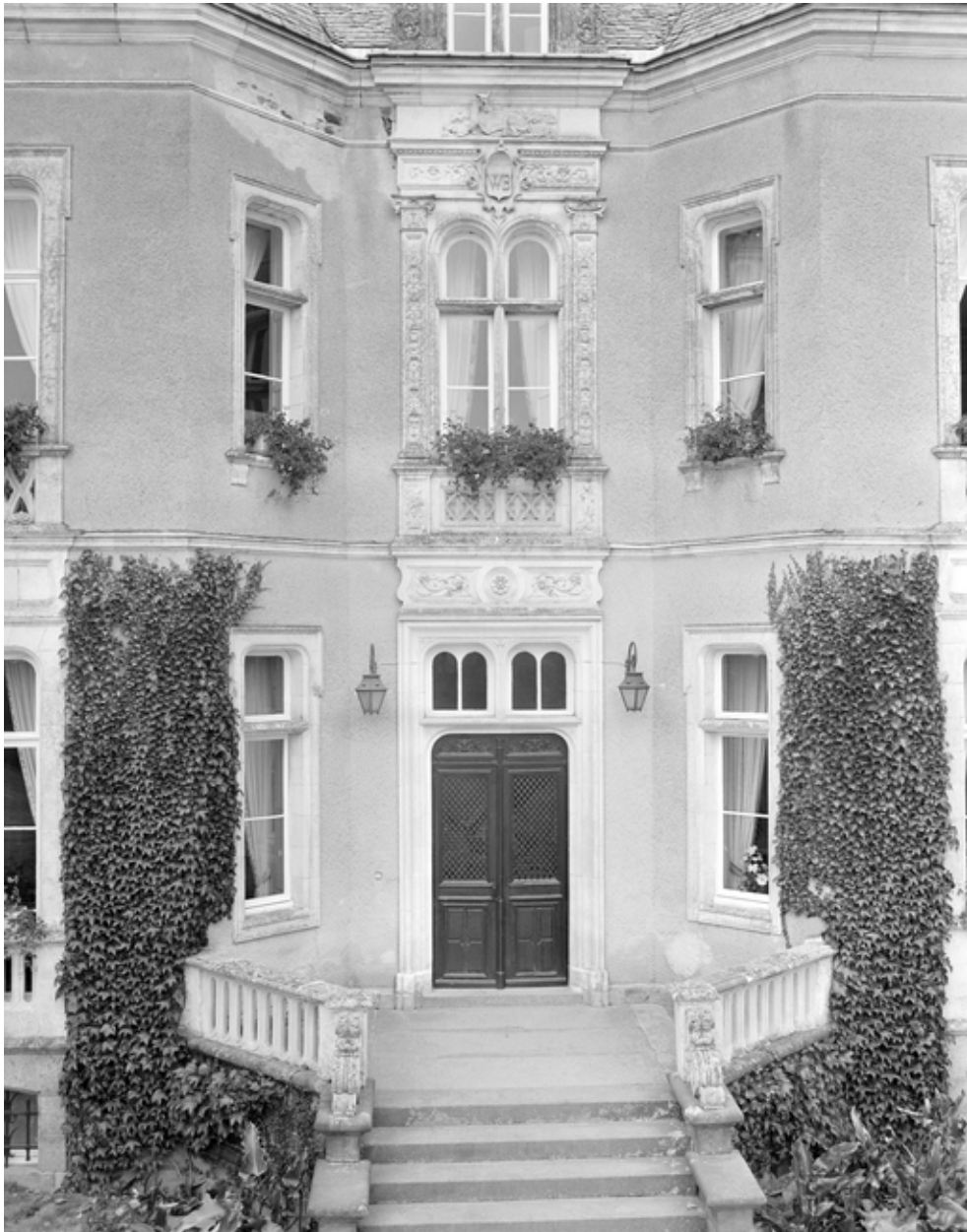
Elévation sud, détail de la travée centrale.
