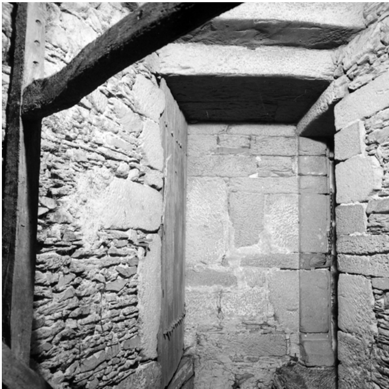
Maisons A et B, tourelle d'escalier, niveau du grenier.
