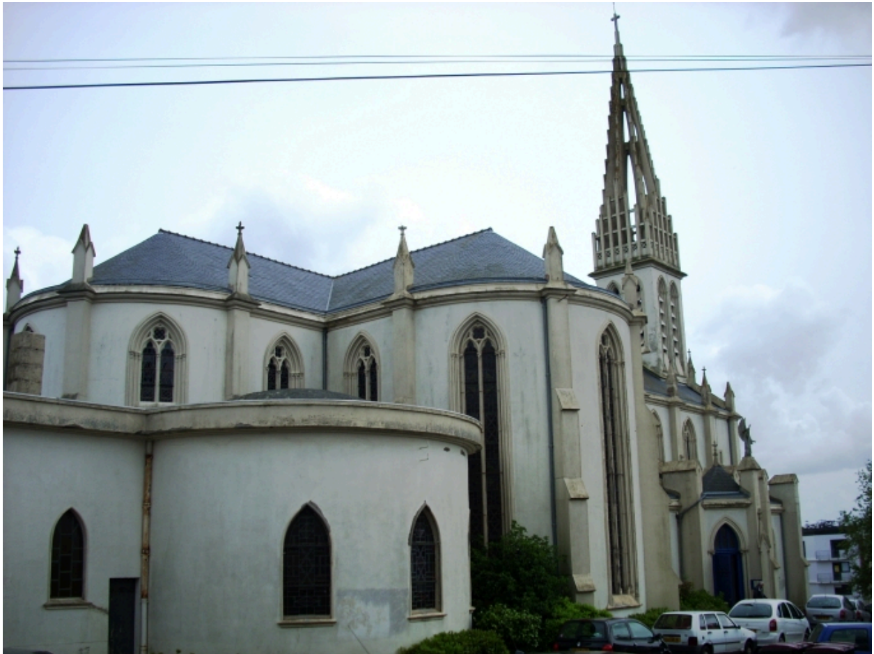
Brest, église Saint-Marc : vue générale nord-est
