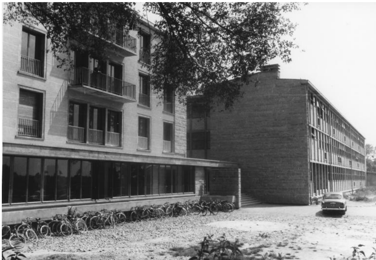
La façade du lycée (administration, logements de fonction, entrée, externat), ca. 1960, avant la construction du garage à vélos !
