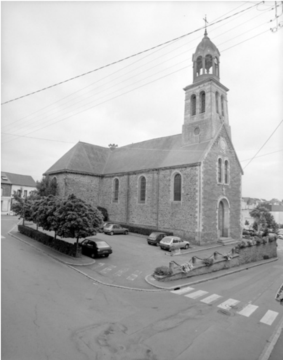
Vue générale nord ouest
