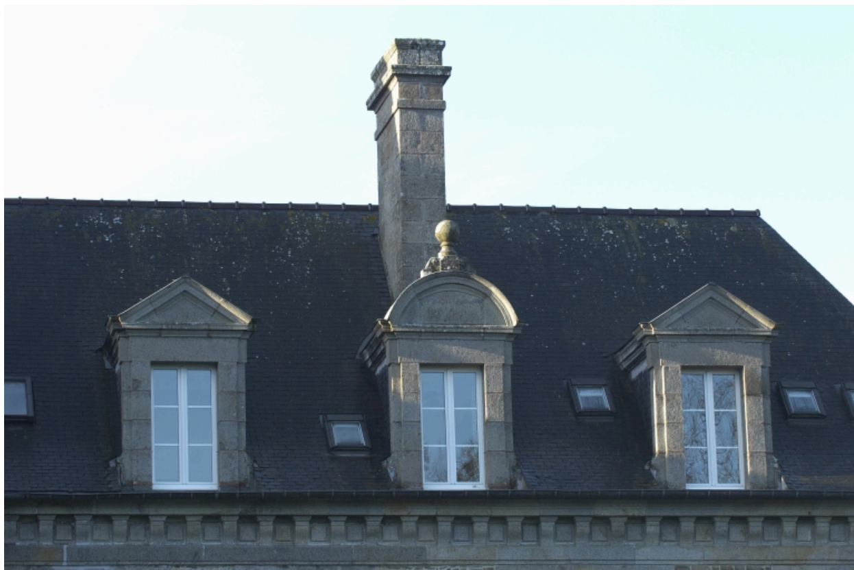
Détail des baies de l'aile ouest
