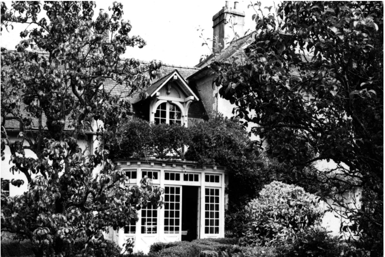
Façade ouest : détail de la véranda
