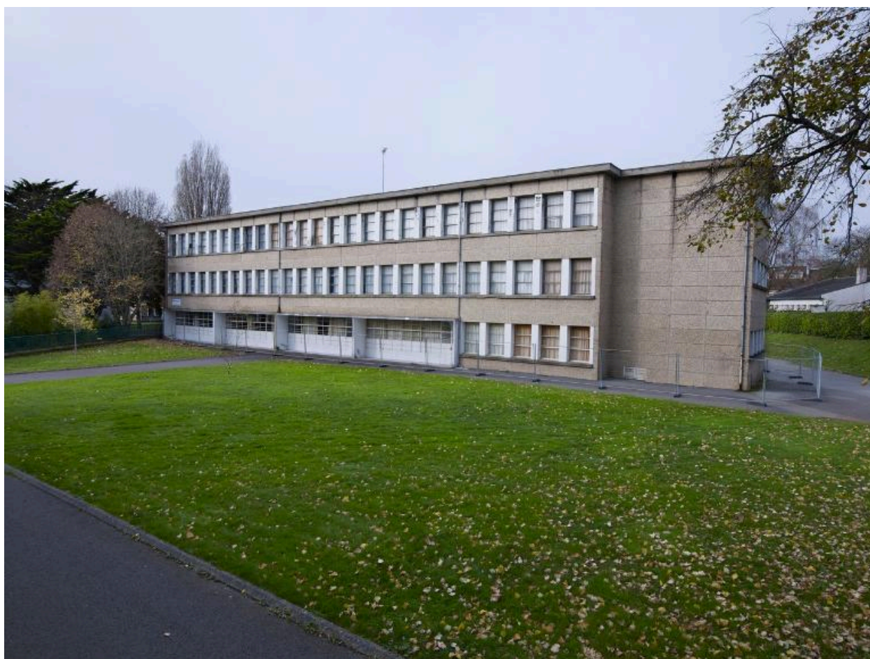
Vue d'ensemble de la façade avant (sud-est) d'un externat désaffecté.
