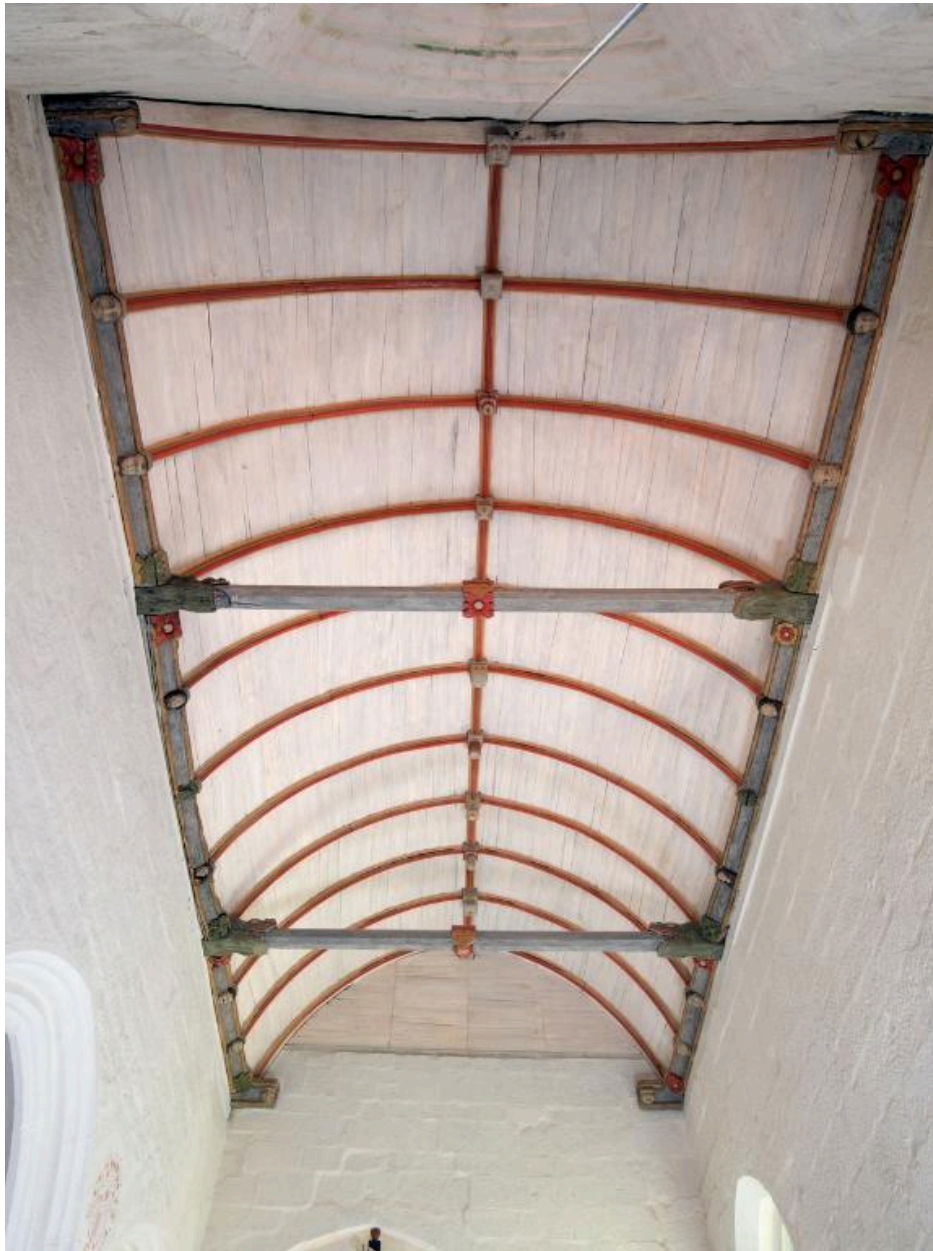
Charpente de la nef après restauration
