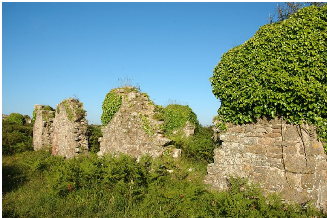
Vue générale du fort Cézon : caserne ruinée
