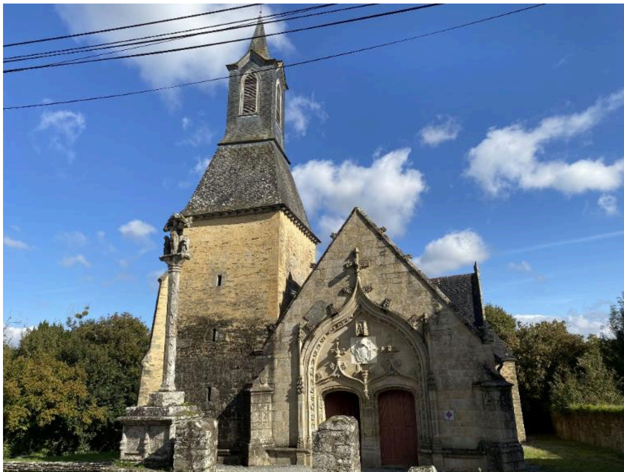
Vue générale sud
