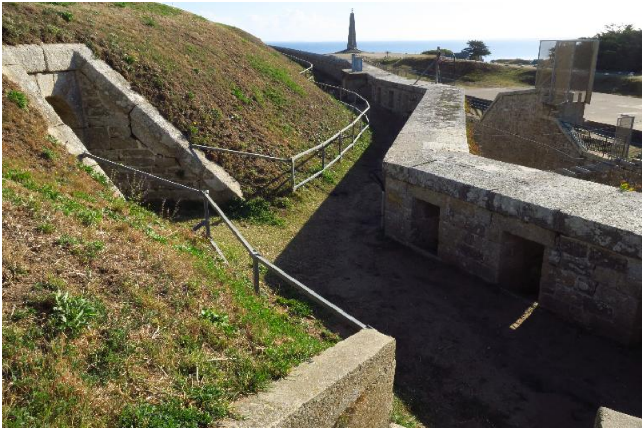
Saint-Pierre-Quiberon, fort de Penthievre, enceinte, parapets à la jonction de la face sud du redan et de la branche sud-ouest.
