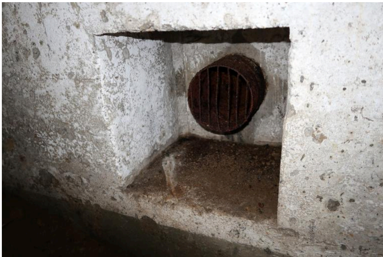
Vue de l'entrée sud remblayée : niche murale avec tuyau et sa grille de protection
