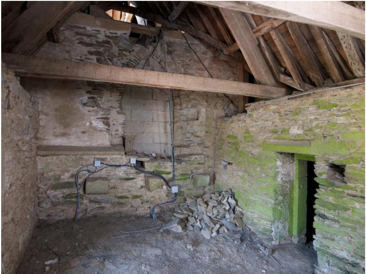
Construction d'angle nord-est. Vue intérieure de la pièce haute située à l'est avec ancienne fenêtre donnant sur le vaisseau central
