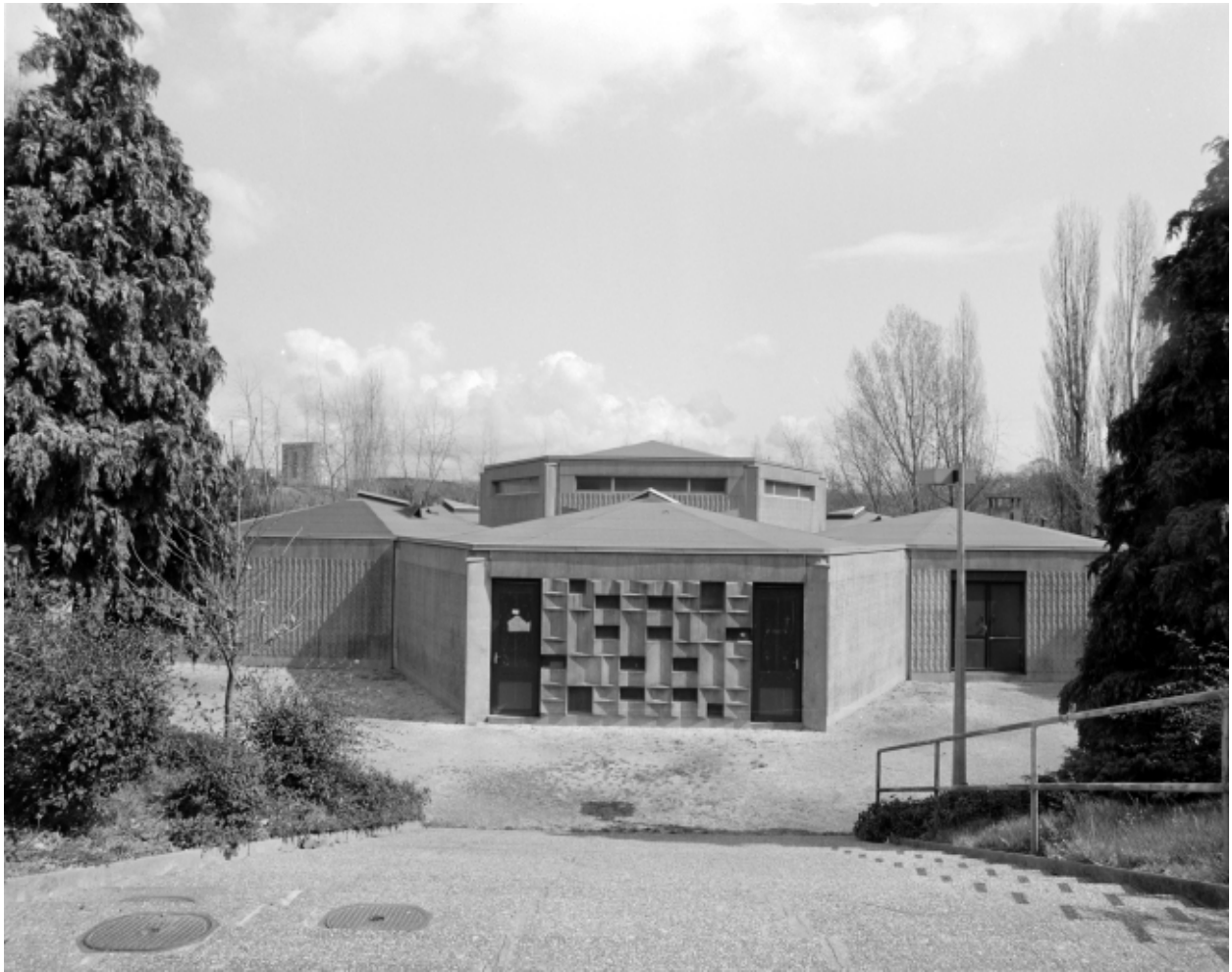
Elévation Ouest : vue générale
