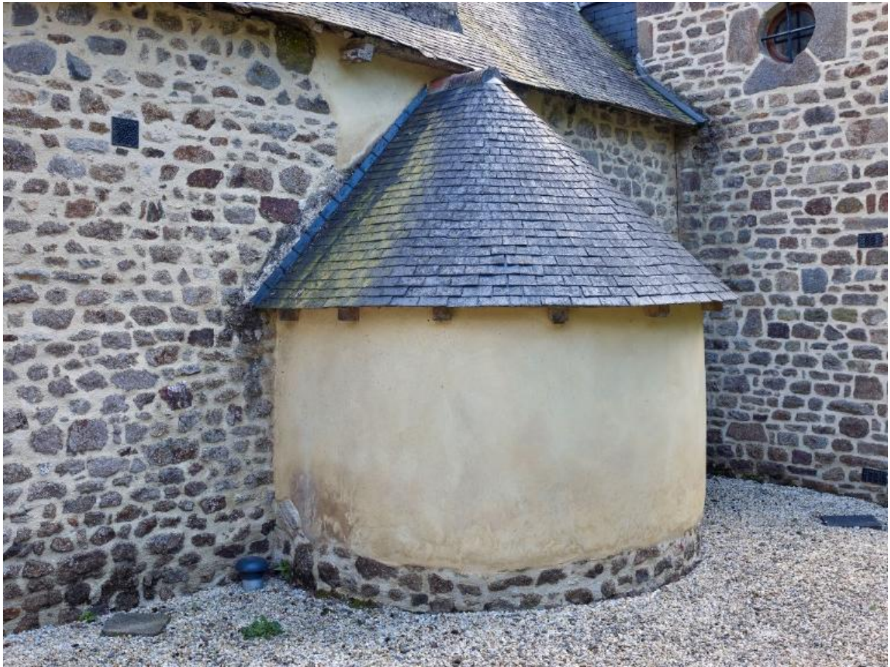
Four à pain sur la façade arrière de la dépendance
