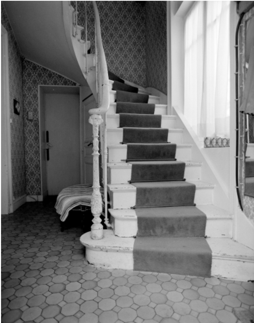
Détail de l'escalier intérieur 1ère volée vue de face.
