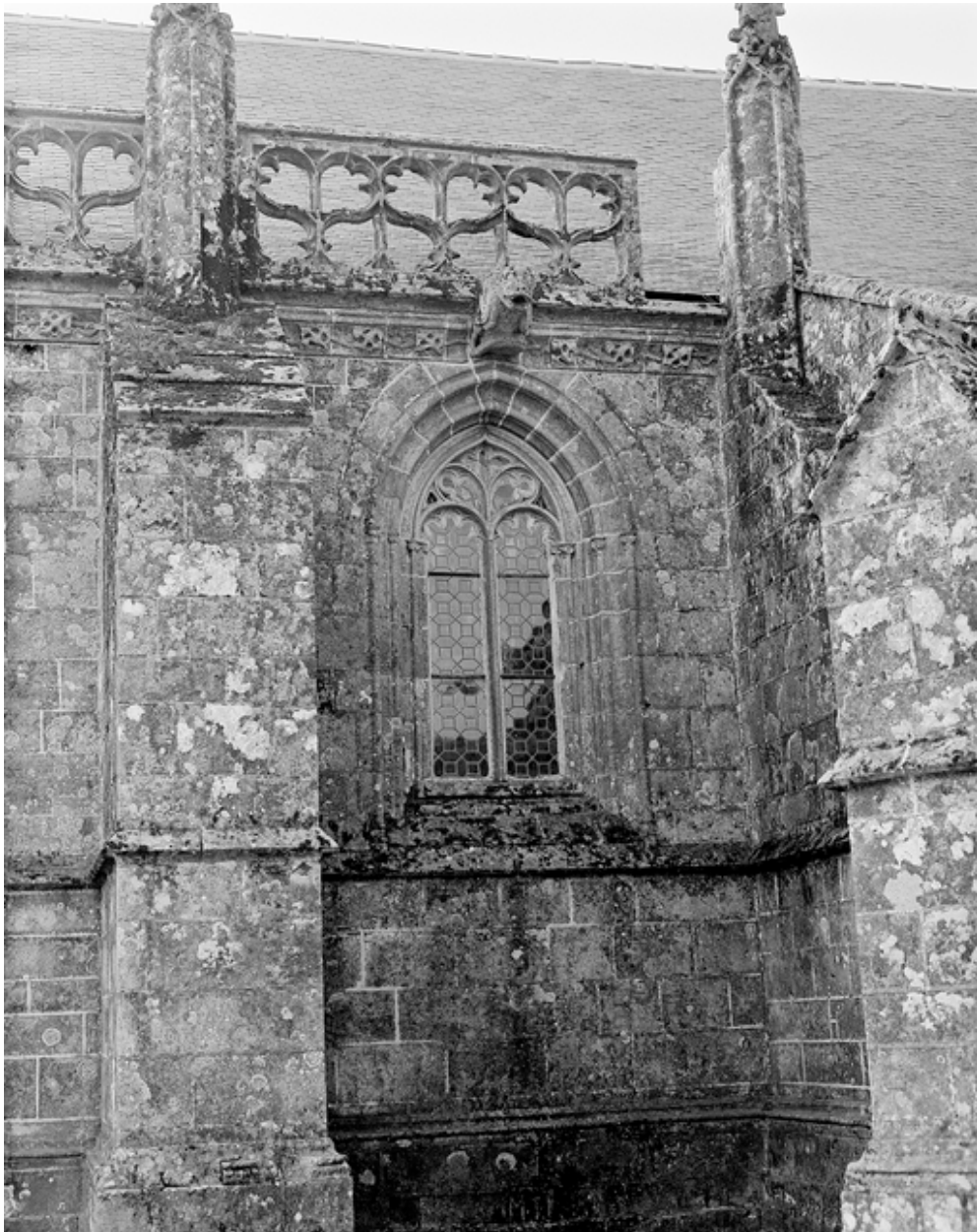
Façade nord, détail de la fenêtre du choeur, deuxième travée.
