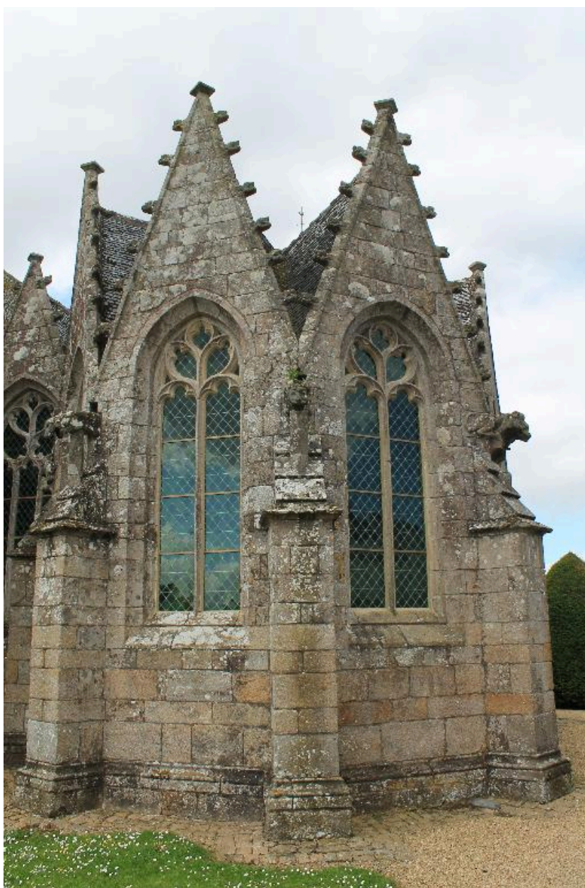
Chevet de la chapelle nord de l'église, devenue sacristie, de face
