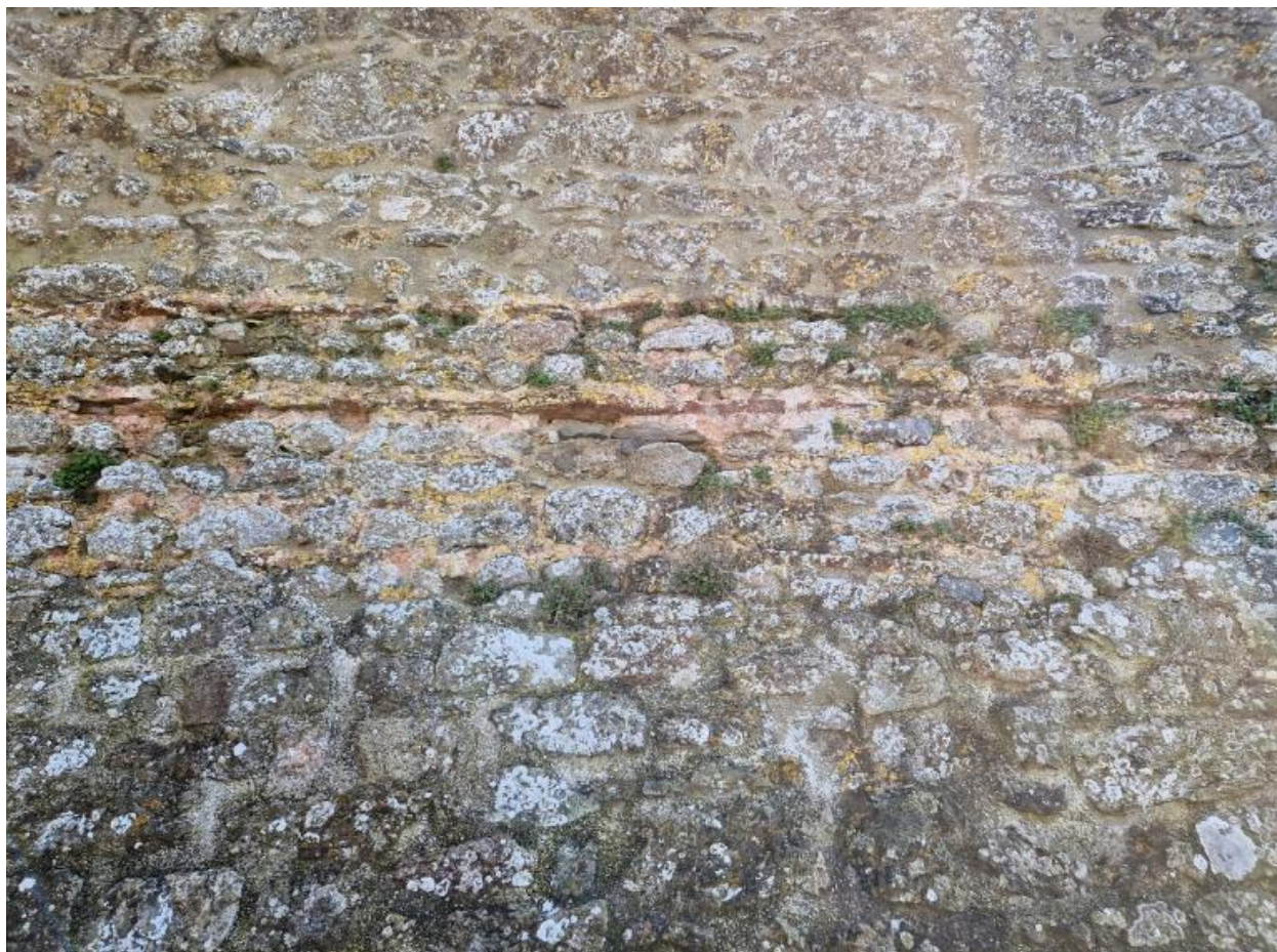
Vue de détail de l'élévation nord de la basse-cour : maçonnerie mêlant moellon et chainage en brique correspondant au niveau d'occupation gallo-romain
