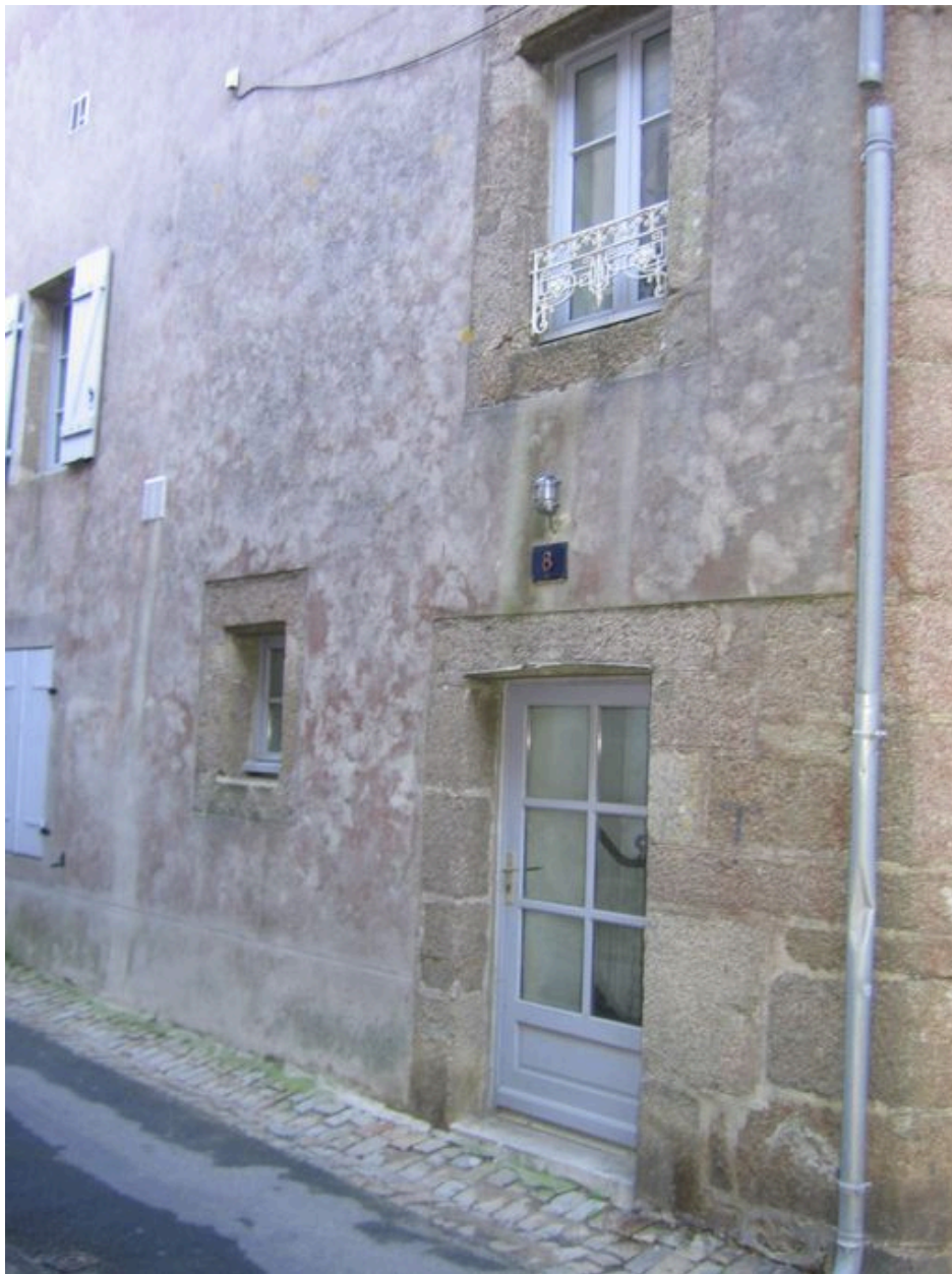
Vue antérieure de la maison n° 43 rue de Dixmude (n° 8 rue de Reims)
