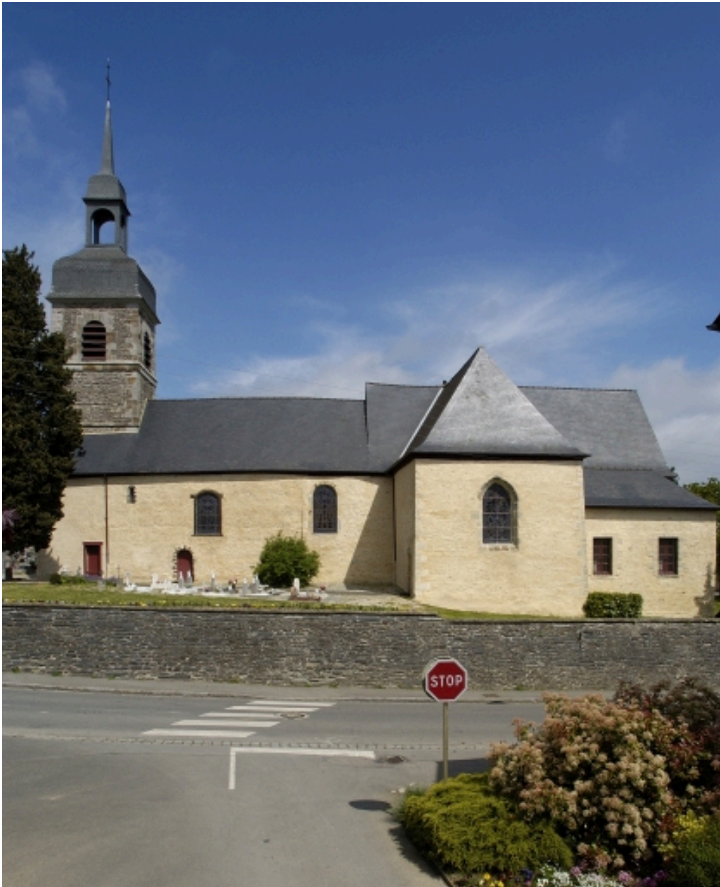
Vue sud de l'église
