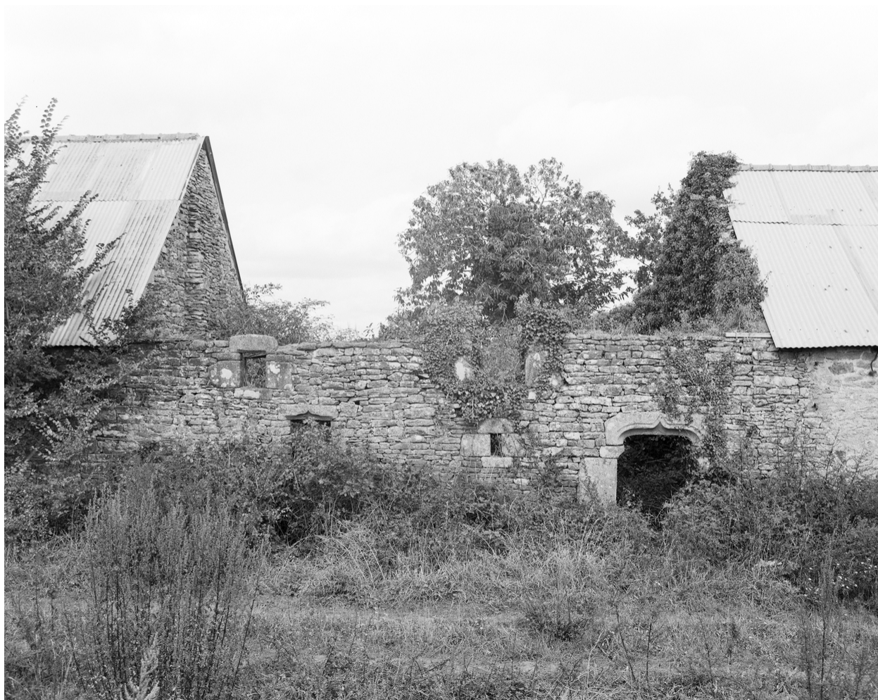
Collogodec, maison en ruines, élévation sud.
