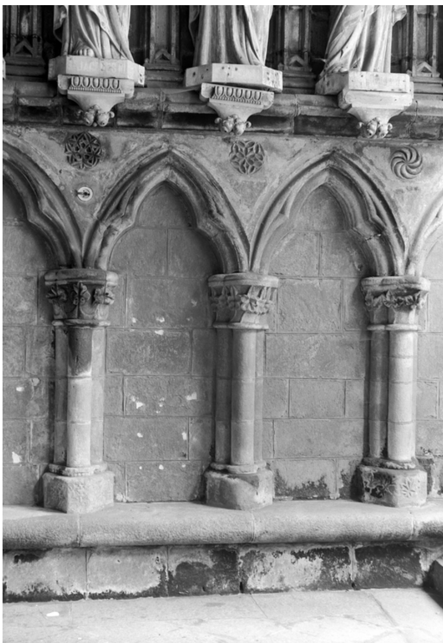
Porche sud, intérieur : mur est, détail des arcades 2 et 3 au sud
