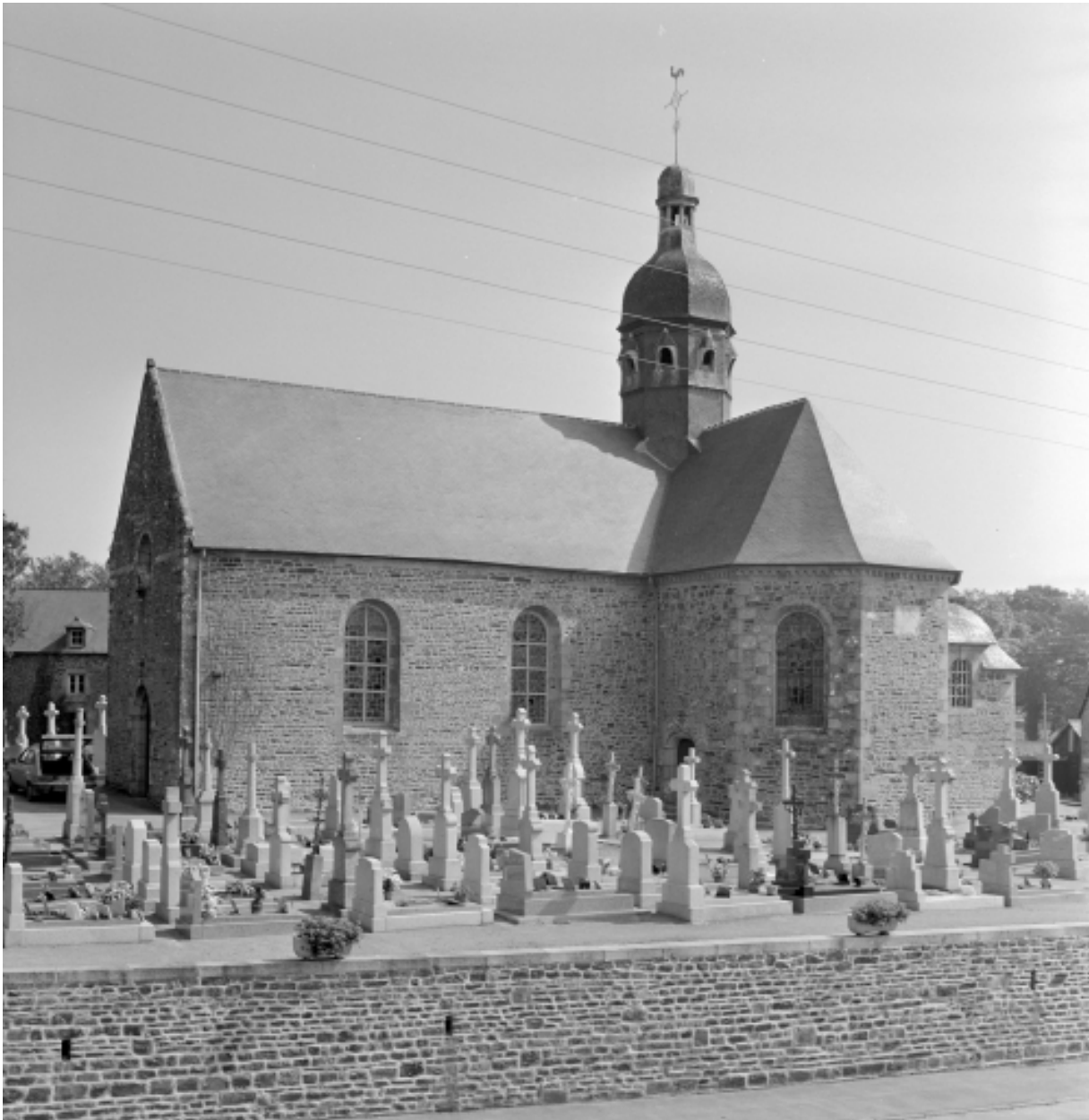
Elévation Sud-Ouest : vue générale
