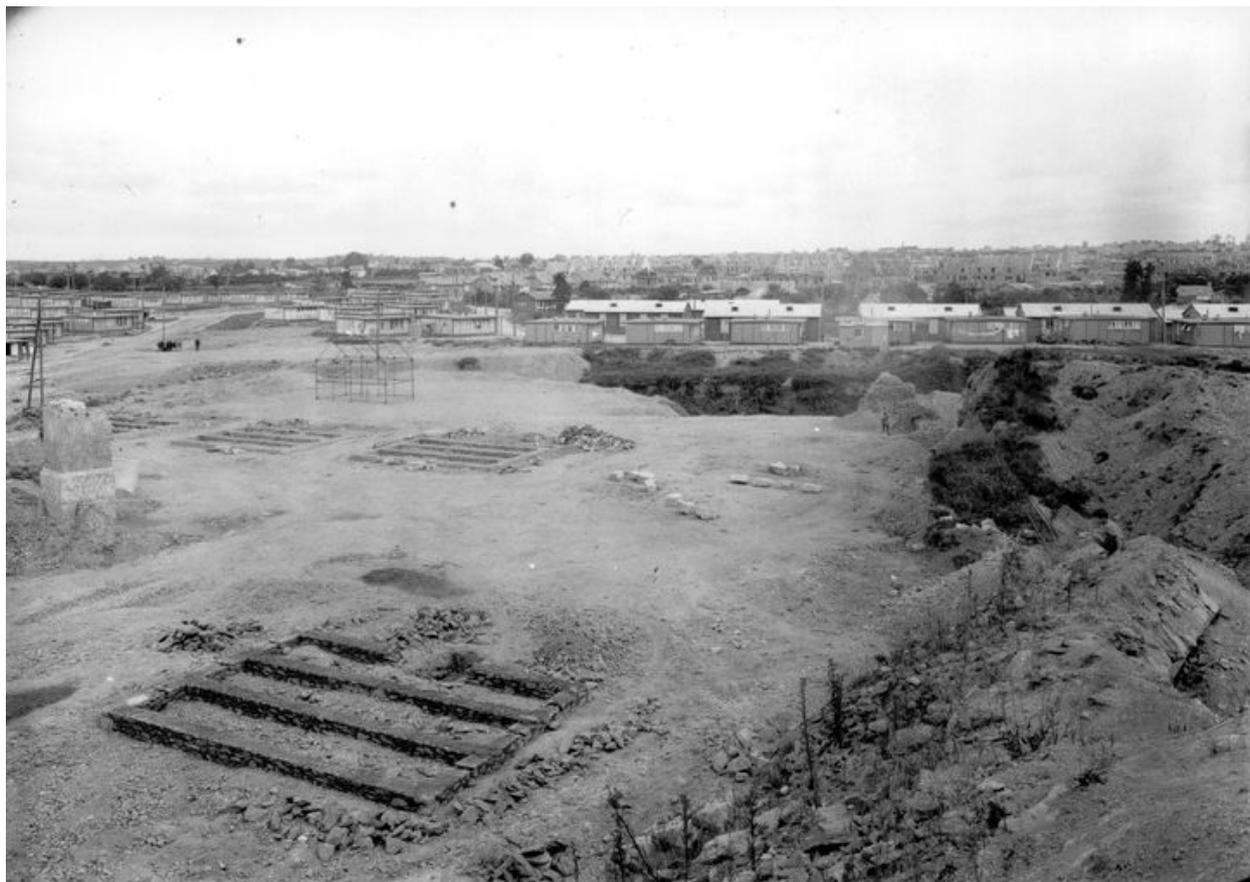
Vue de Brest vers 1950 : le Bouguen. Travaux d'arasement et de terrassement des fortifications. Installation des baraques pour le relogement des sinistrés. Fondation d'une baraque au premier plan
