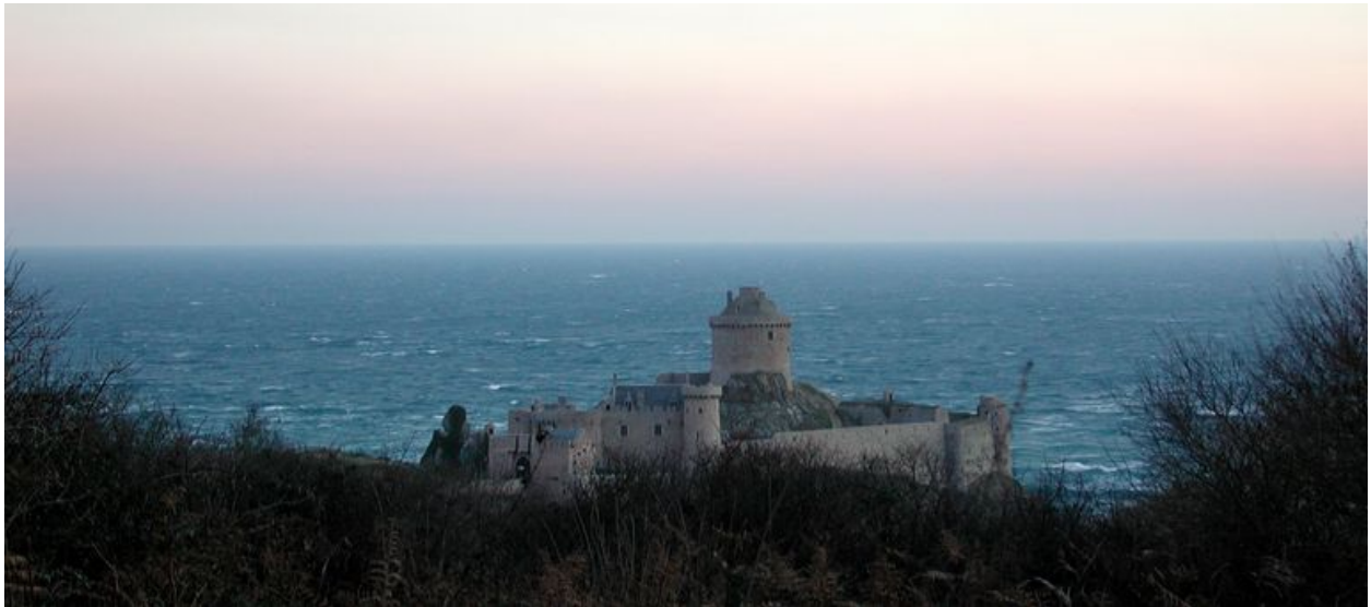
Vue du Fort La Latte
