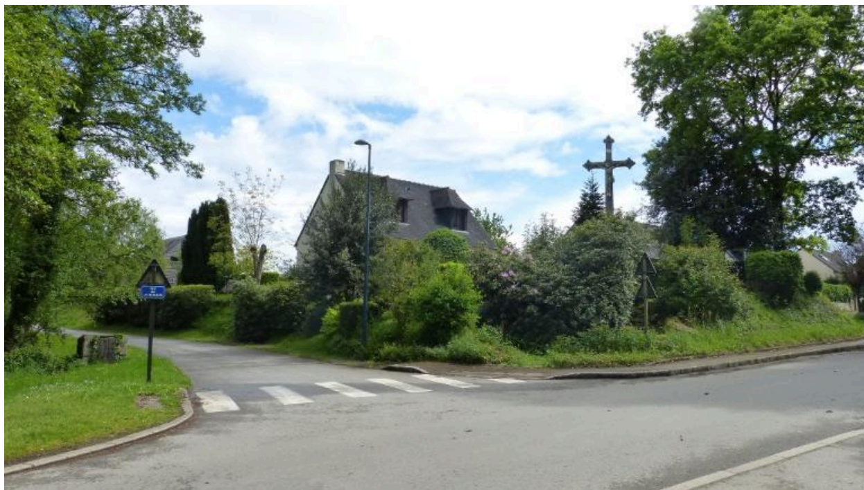
Vue générale nord ouest
